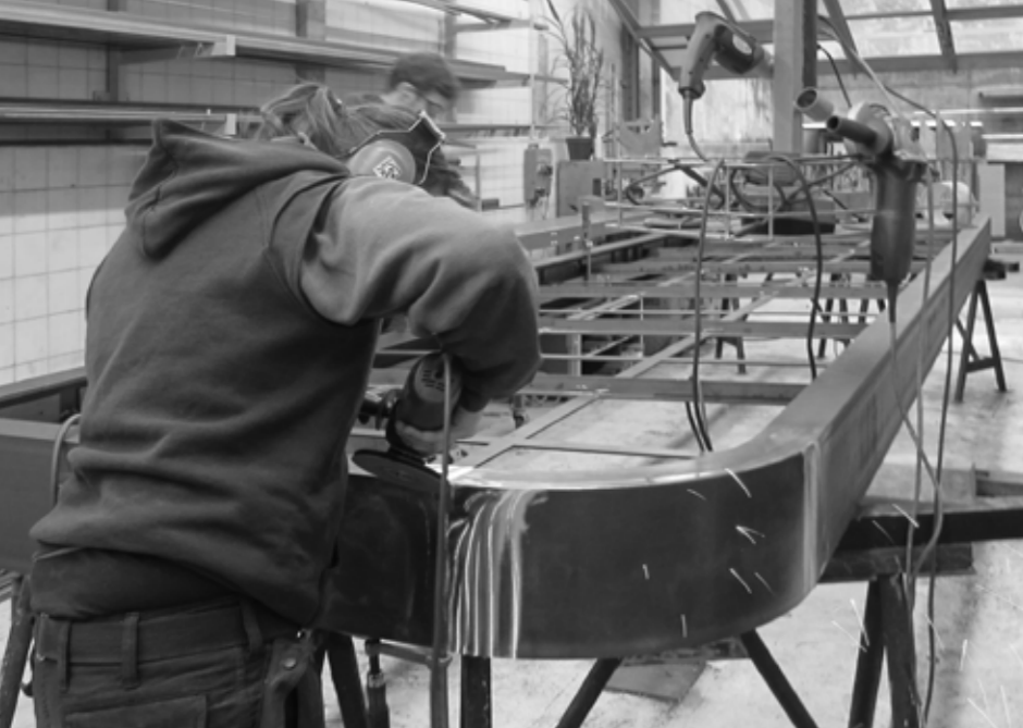
neubau vordach kafischnaps
