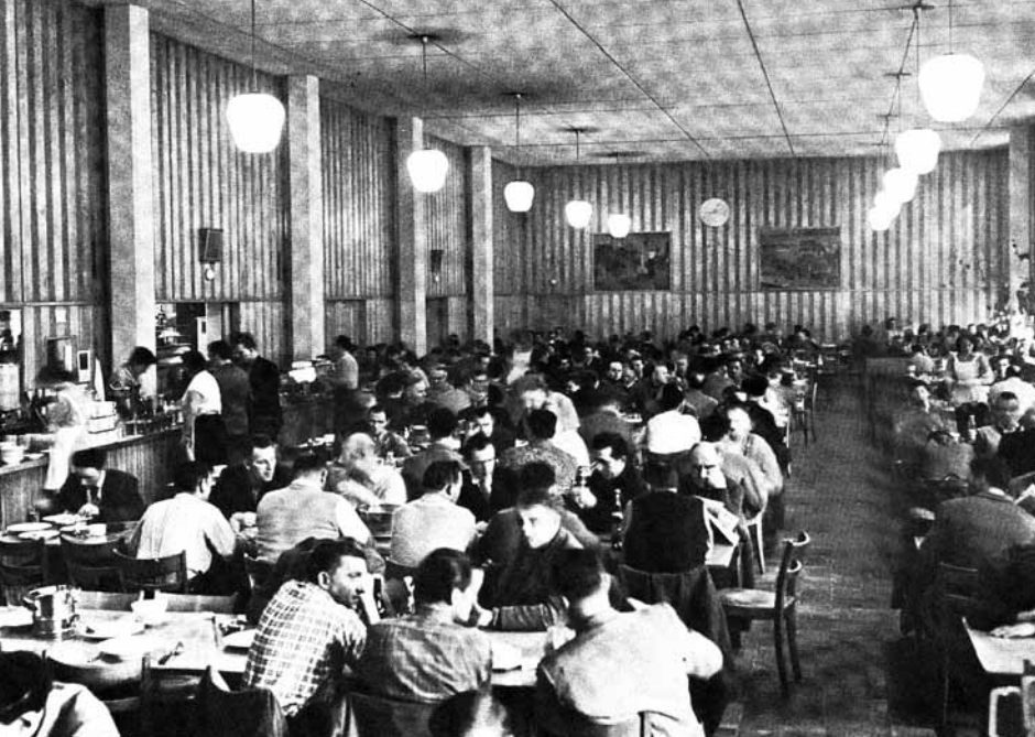
umbau kantine escher wyss
